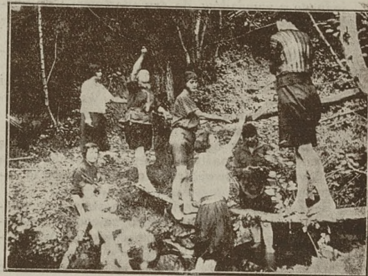
Kładka, zbudowana. (Obóz Ch. Krakowskiej. Jachówka 1925).
