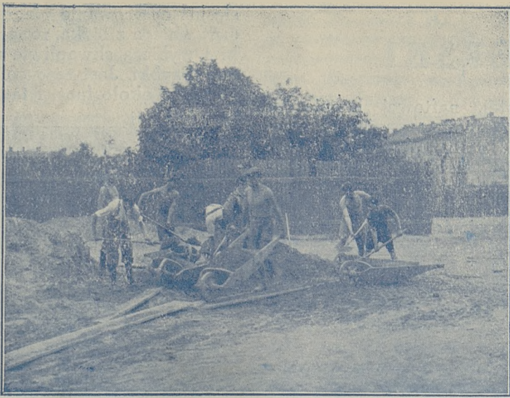
Niwelowanie boiska Sokoła II (1025 taczek ziemi przewieziono na drodze 51 kilometrów 450 metrów. Wakacje 1928 r.). Fot. A. H.
