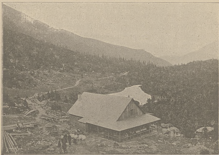
Tymczasowe schronisko Tow. Tatr. przy Morskiem Oku.
