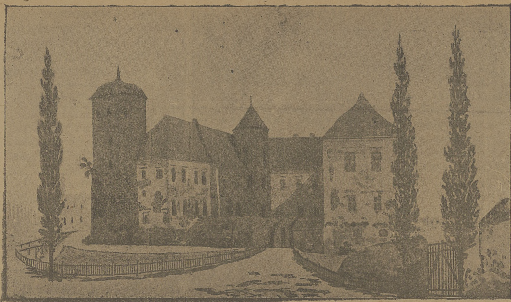
Zamek w Koźminie przed przebudowaniem.
