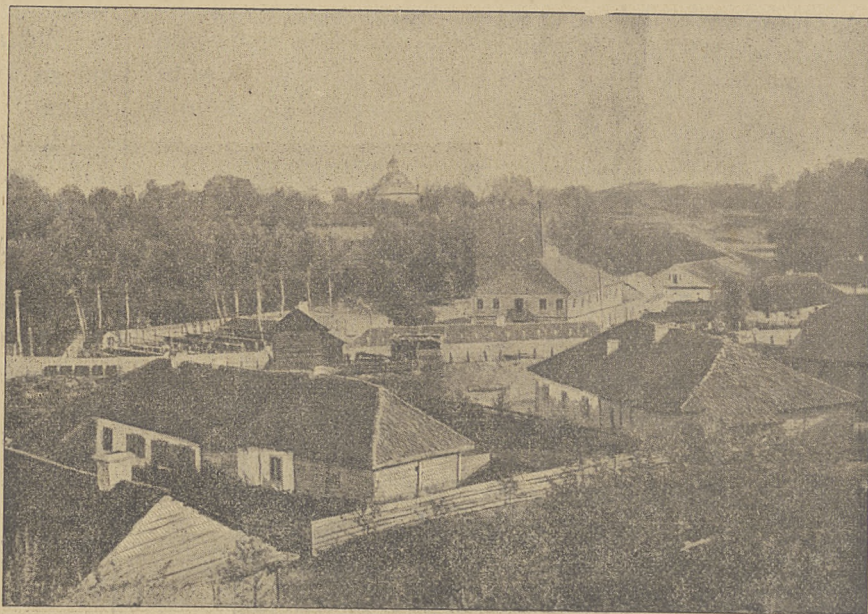
Dawna kaplica zamkowa, obecnie kościół parafialny wraz z ogrodem proboszczowskim w Korcu.
