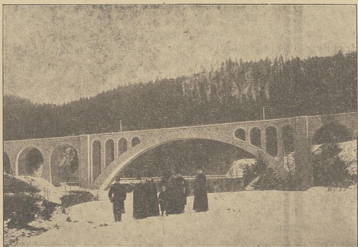
Most kolejowy, kamienny, na Prucie w Jaremczu, mający największe rozpięcie (65 metrów) wśród wszystkich mostów na świecie.
