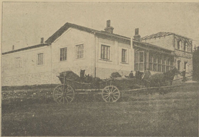
Szpital w Starachowicach.
