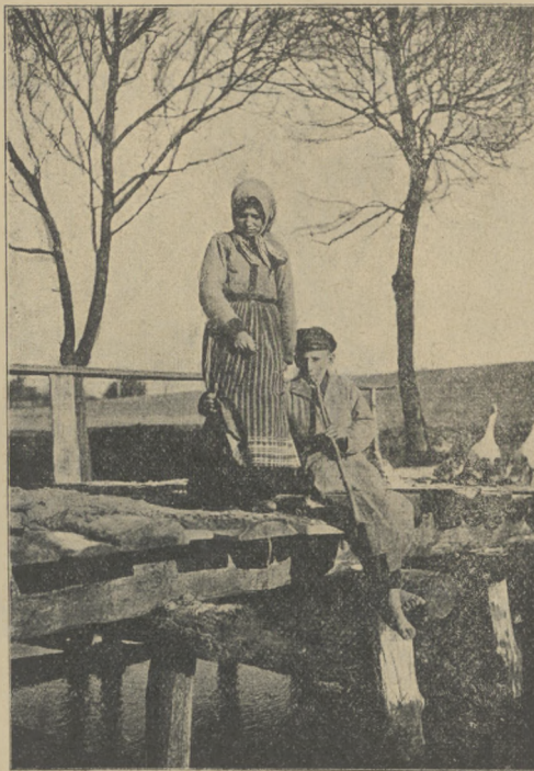
Na mostku pod Opatowem.
