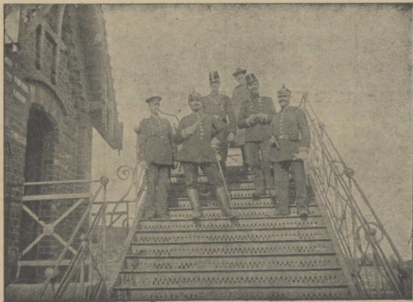
Mostek jęzorski na Przemszy, który jest własnością kopalni myśłowickiej, zamknięto.
