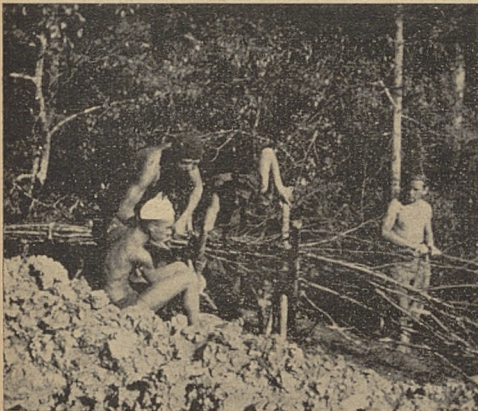
Wykonywanie drenu faszynowego
