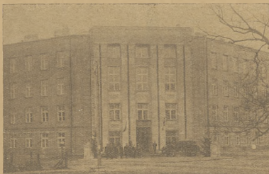
Nowowytbudowany gmach Dyrekcji Lasów Państwowych w Siedlcach.
