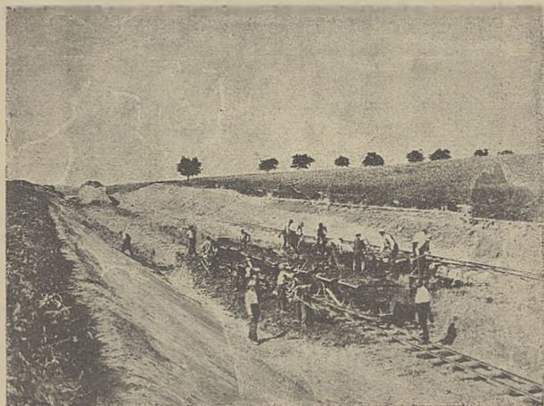
Z budowy kolei Kraków—Miechów
