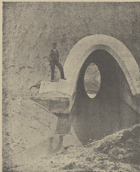
Z budowy kolei Kraków—Miechów
