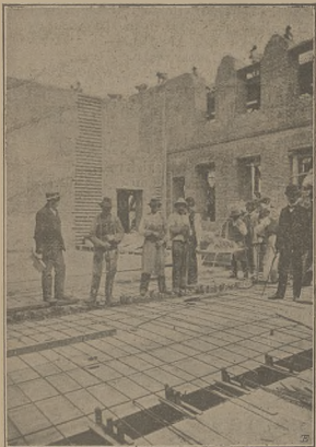
Układanie stropu żelazno-betonowego.
