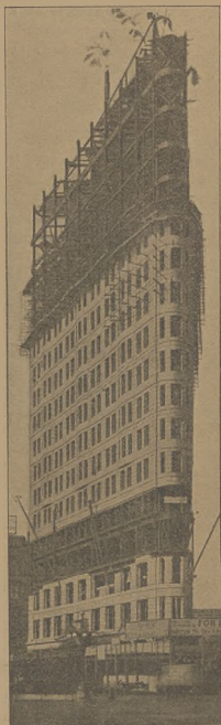
Rys. 6. BUDOWA WIEŻOWNICY „FLATIRON”.
