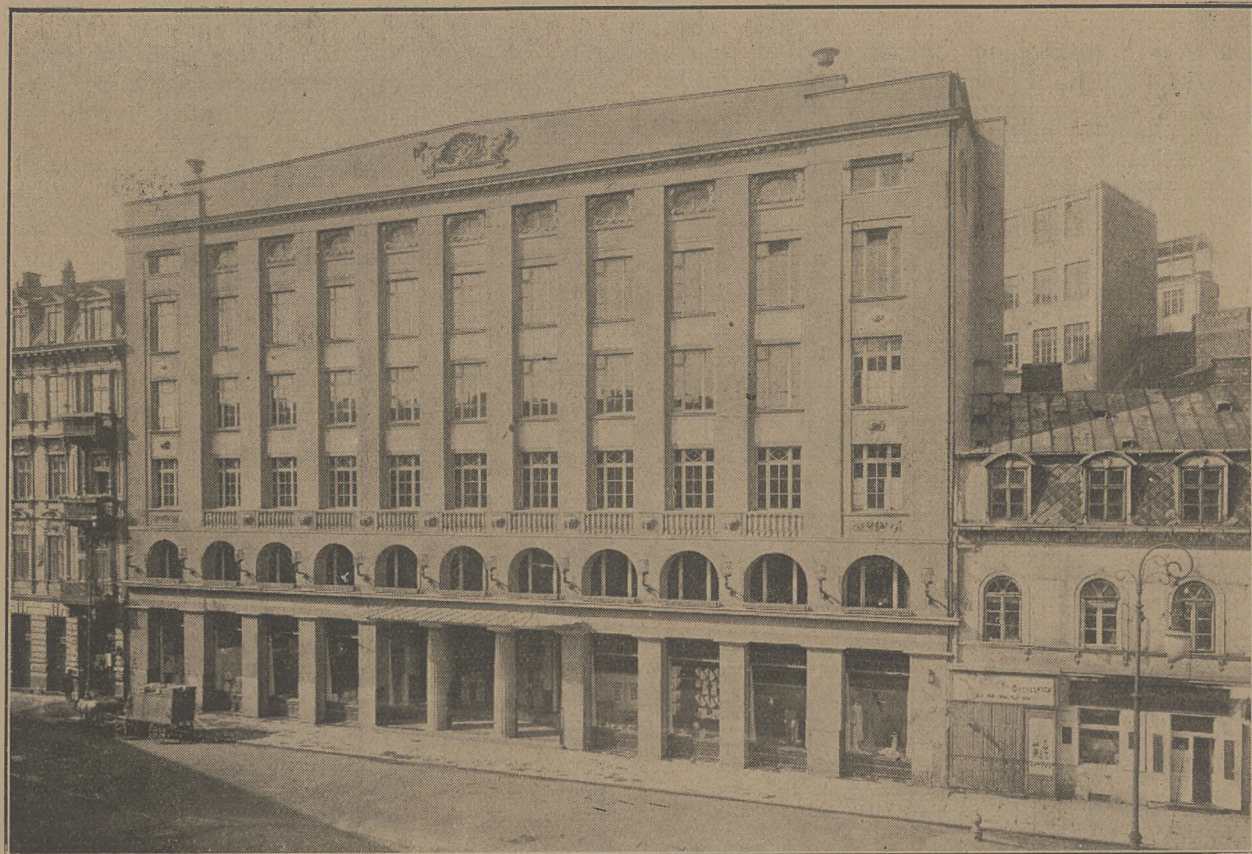
Gmach Domu Towarowego „B-cia Jabłkowski” w Warszawie (Bracka 25). Jedną z najcelniejszych budowli projektowanych przez ś. p. arch. Jankowskiego (wykonany przez firmę „Lilpop i Jankowski”).
