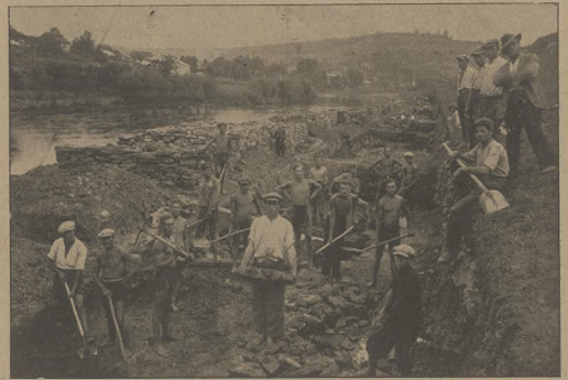
Roboty ziemne przy kopaniu kanału dla miejskiej elektrowni wodnej w Buczaczu.
