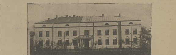
Nowo wybudowany gmach Rady powiatowej w Rohatynie. Budynek posiada wodociąg, centralne ogrzewanie i kanalizację. Koszt budowy wynosi około 360.000 złotych z tym, że powiat na budowę gmachu nie zaangażował żadnych długów. W gmachu tym mieszczą się biura Starostwa powiatowego, Wydziału powiatowego, Kasy Oszczędności i Urzędu rozjemczego.
