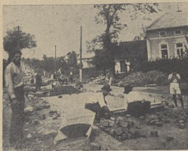
Budowa podmiejskiej drogi z kostki pod Drohobyczem.
