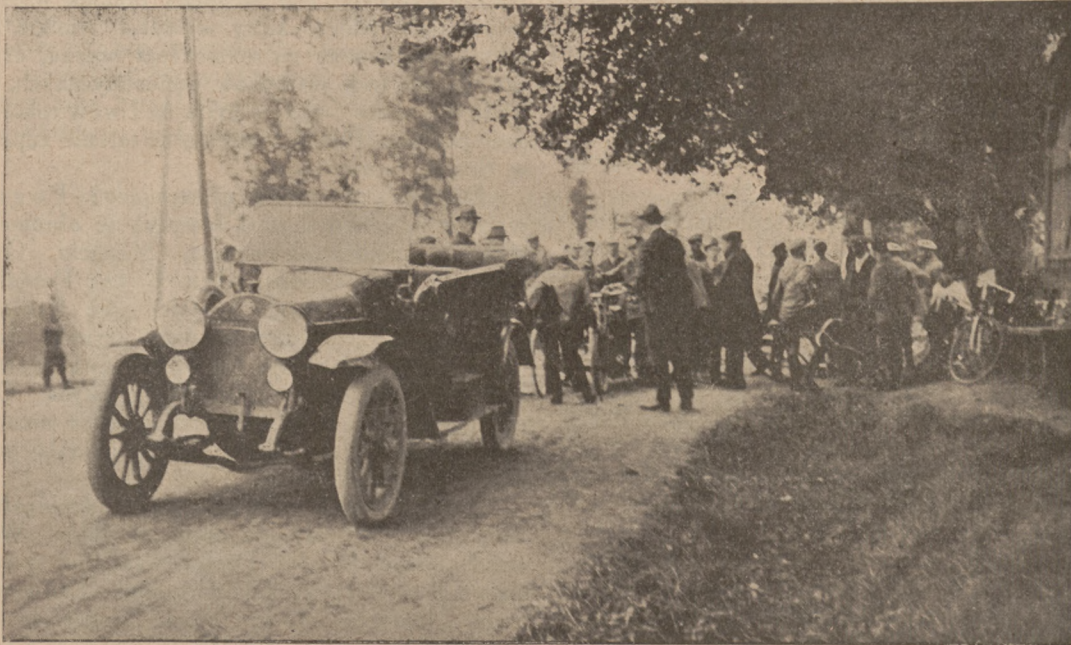
Wyciąg górski Kraków—Zakopane. Na starcie.
