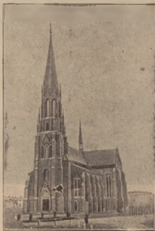
Kościół św. Trójcy w Bytomiu.
