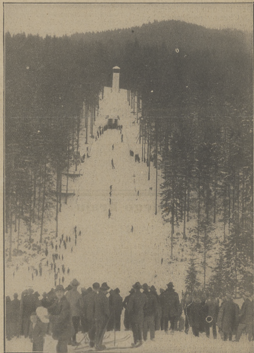
OGÓLNY WIDOK SKOCZNI NARCIARSKIEJ W GŁĘBCU
