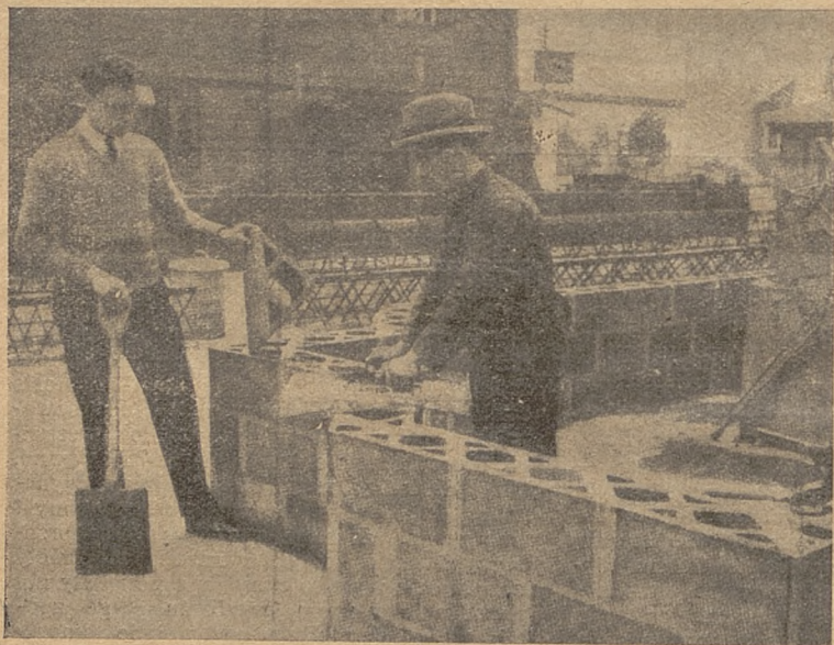
Budowa domu na wystawie w Wembley.
