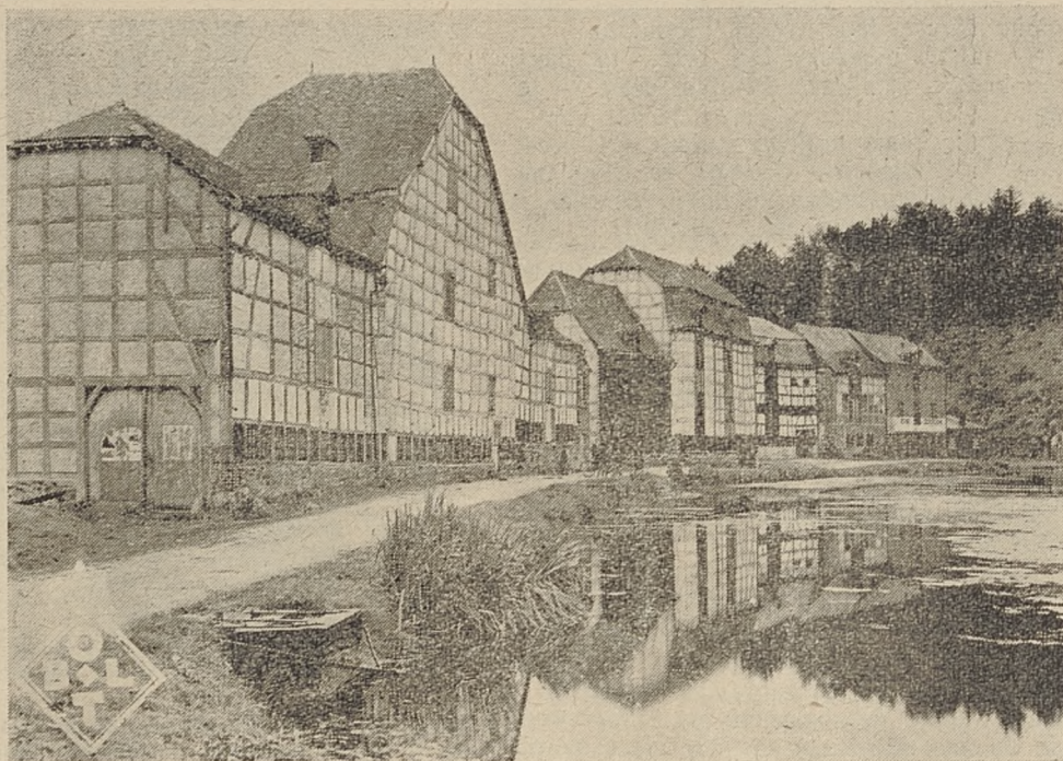
Romantyczny widok starych spichrzów w Stavelot w Belgii
