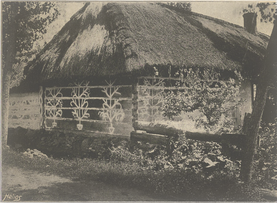
Malowanki na ścianach.
