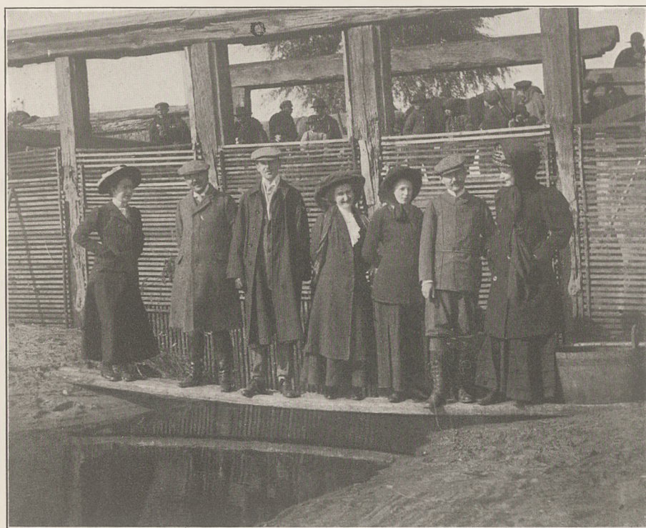
Wielki upust na stawie. „Okręt” po opuszczeniu wody.
