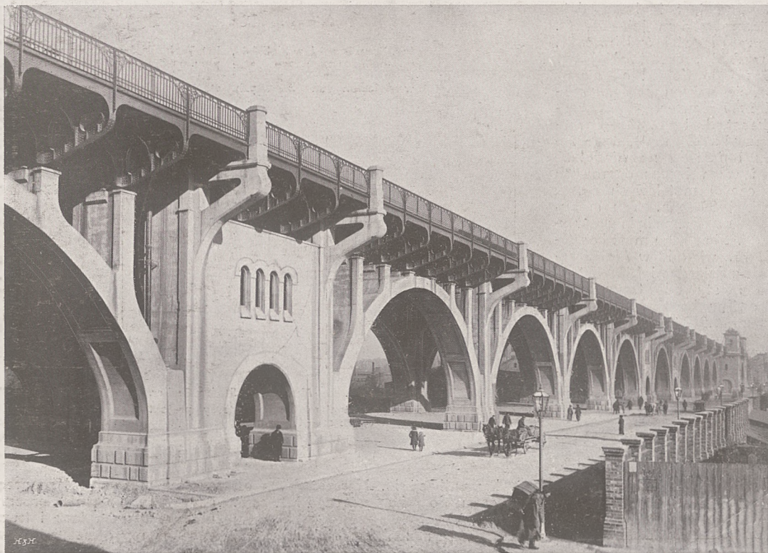
Zewnętrzny widok części wiaduktu w Alei Jerozolimskiej.
