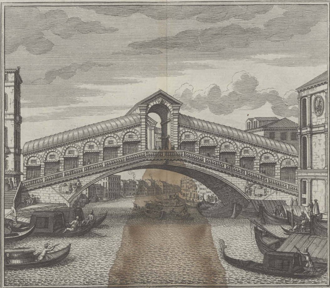
Ponte di Rialto
