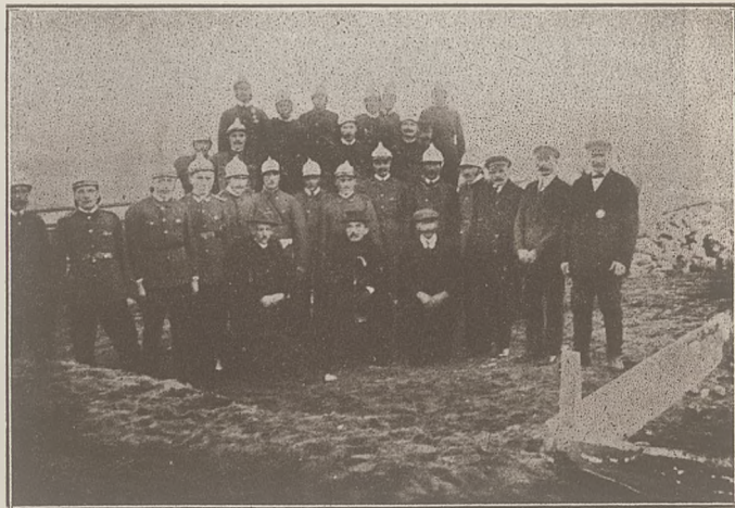
Ochotnicza Straż Pożarna we Wrzosowej (pow. Częstochowski) z drużem prezesem inż. J. Rutkowskim na czele. Zdjęcie dokonane na placu, gdzie wzniesiona ma być remiza straży.
