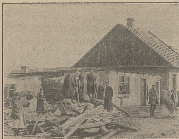
W dniu 22-im kwietnia r. b. Straż Poż. Och. w Pacanowie energicznie i sprawnie opanowała pożar budynku, chroniąc w ten sposób od zagłady cały szereg domostw sąsiednich.
