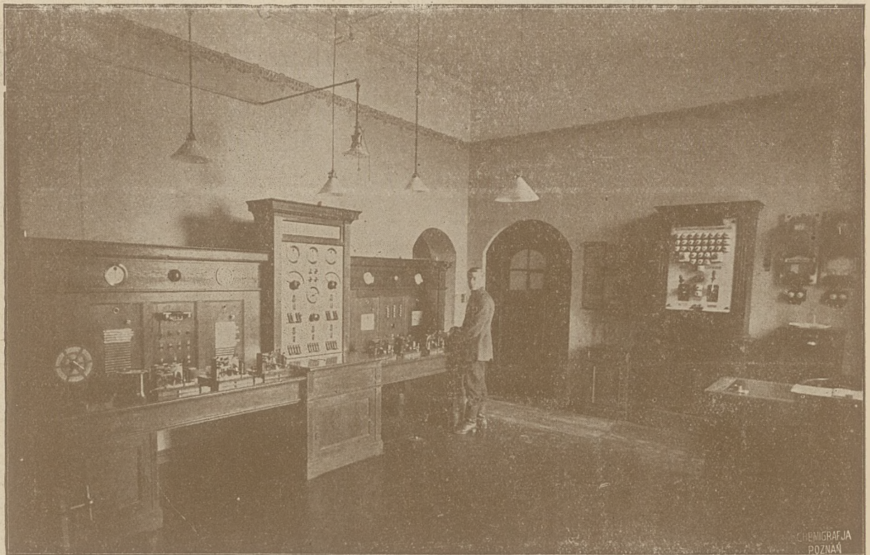
Fot. „Wiadomości Urzędowych Kraj. Ub. Ogn. w Poznaniu”. Stacja automatycznej sygnalizacji w oddziale głównym (1-ym) Straży Poznańskiej.
