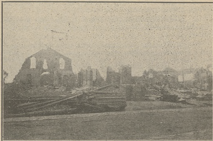
Ogólny widok zniszczenia.
