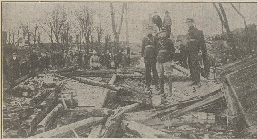
Na zgliszczach masowego pożaru w Porębie, który zniszczył 36 domów mieszkalnych, 30 stodół i 18 innych budowli.
