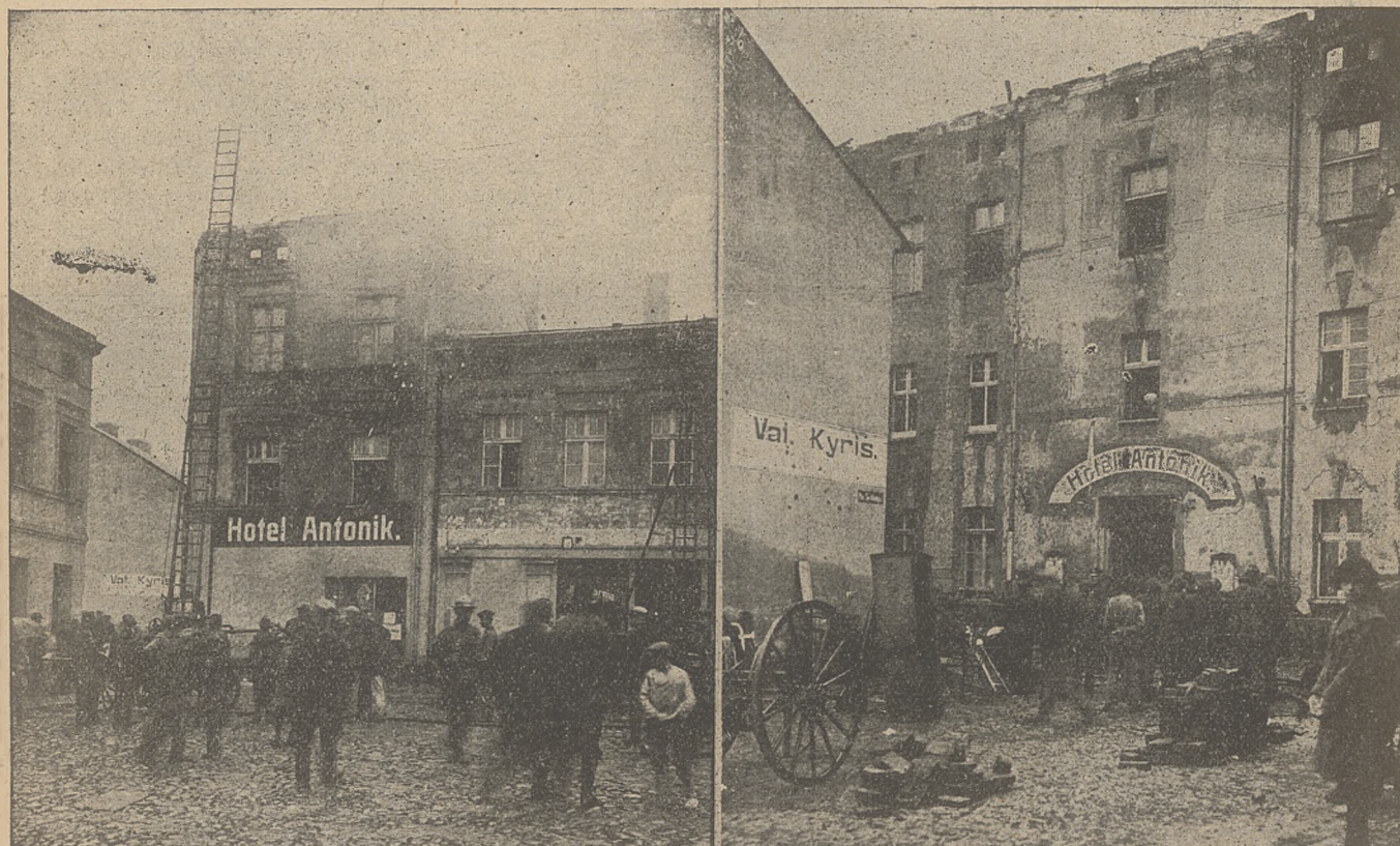
Groźny pożar budynku hotelowego opanowany sprawnie przez Ochotniczą straż pożarną w Lublińcu (Górny Śląsk).
