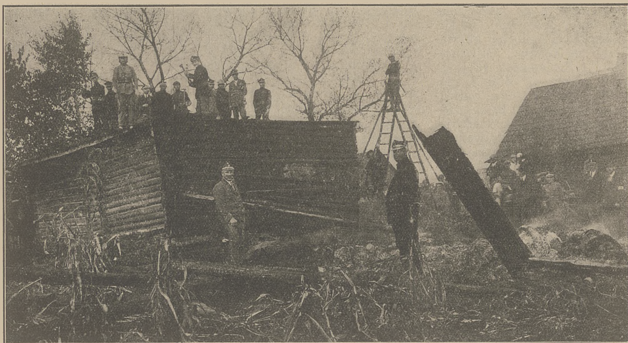
Miasto powiatowe Stolín (woj. Poleskie) odwiedził d. 2 września r. bież. groźny pożar. Rezultaty skutecznej obrony, przeprowadzonej przez miejscową Ochotniczą Straż Pożarną widzimy na powyższej ilustracji. Ocalono części budynków oraz nie dopuszczono ognia do dalszych zabudowań.
