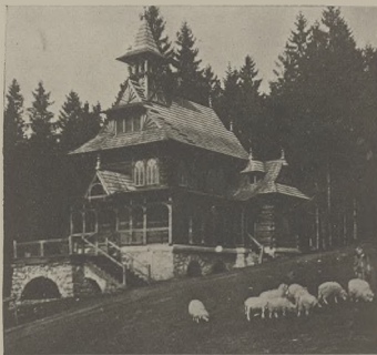
Kaplica w Jaszczurówce. Proj. St. Witkiewicza.
