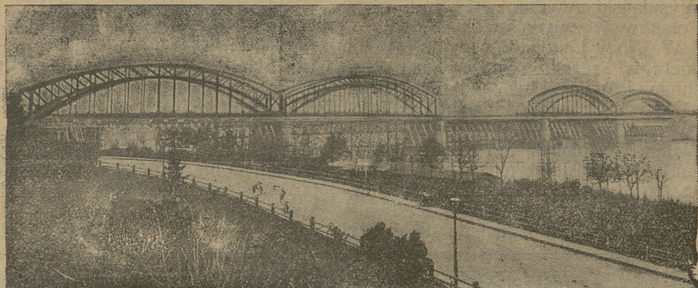
Budowa nowego mostu kolejowego na Wiśle w Warszawie.
