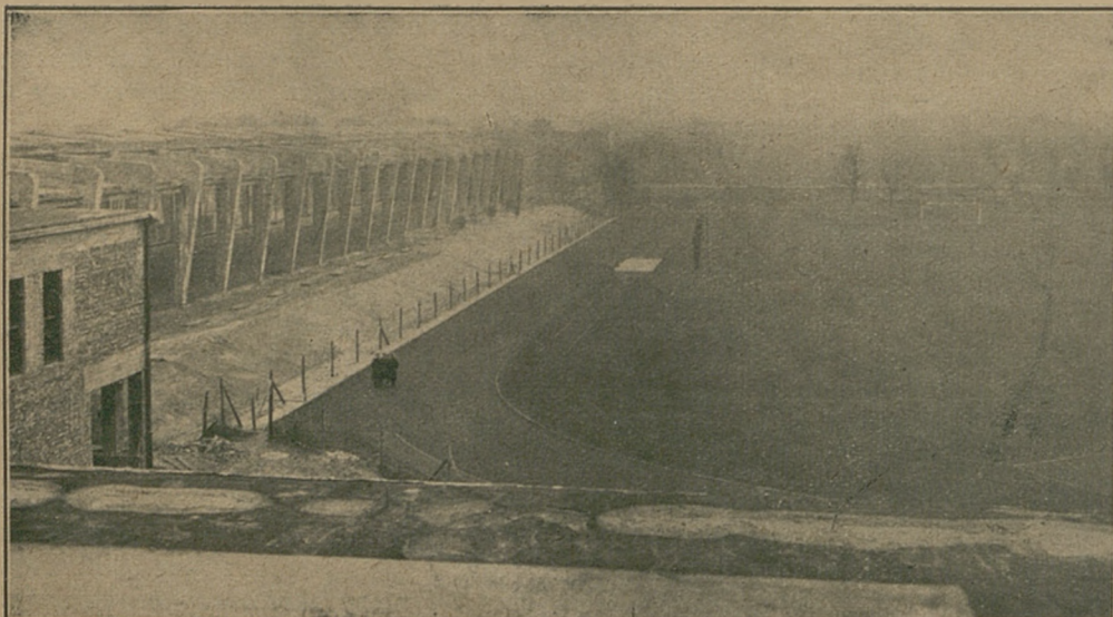
Widok na boisko i budującą się wielką halę sportową na Bielanych.
