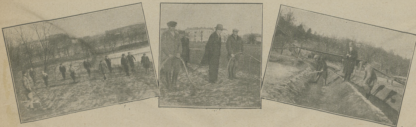
Zimowe prace przygotowawcze w parku szkolnym w Agrykoli (Warszawa), z lewej strony pierwsza zaprawa narciarska, w środku budowa ślizgawki na boisku piłkarskim, z prawej strony—przygotowywanie torów saneczkowych.
