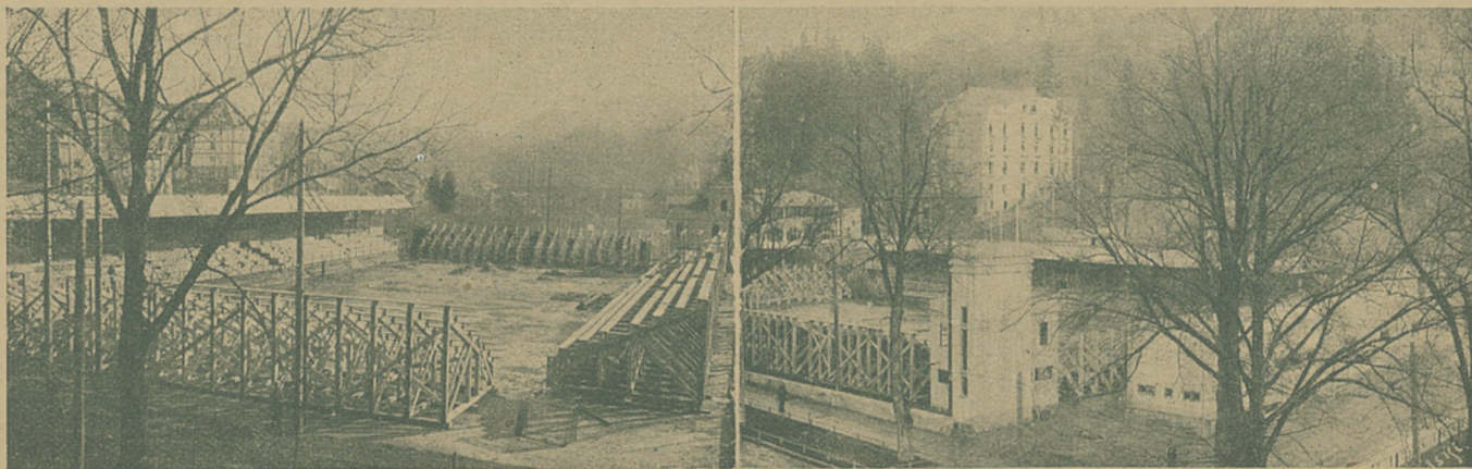
Przebudowa stadionu, na którym rozegrane będą hokejowe mistrzostwa świata.
