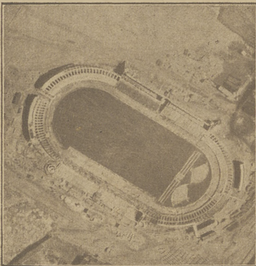
Widok Stadionu miejskiego w Poznaniu. Fotografja dokonana z wysokości 750 mtr.
