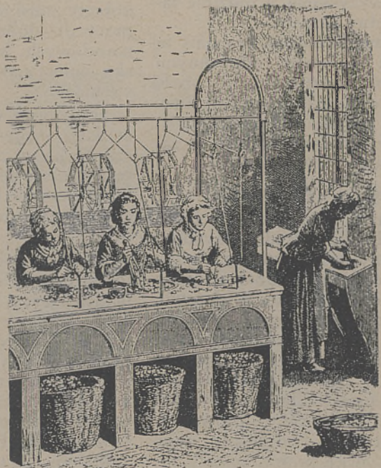
Motowidła, służące do odwijania nici jedwabnej z kokonów zwilżonych w wodzie.
