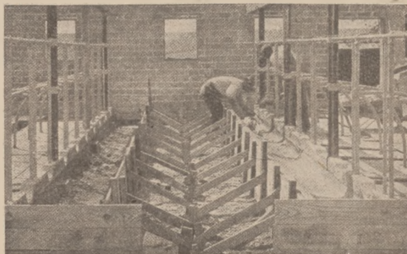
Fig. 10a. Wykonanie żłobów przy środkowym korytarzu karmnym.
