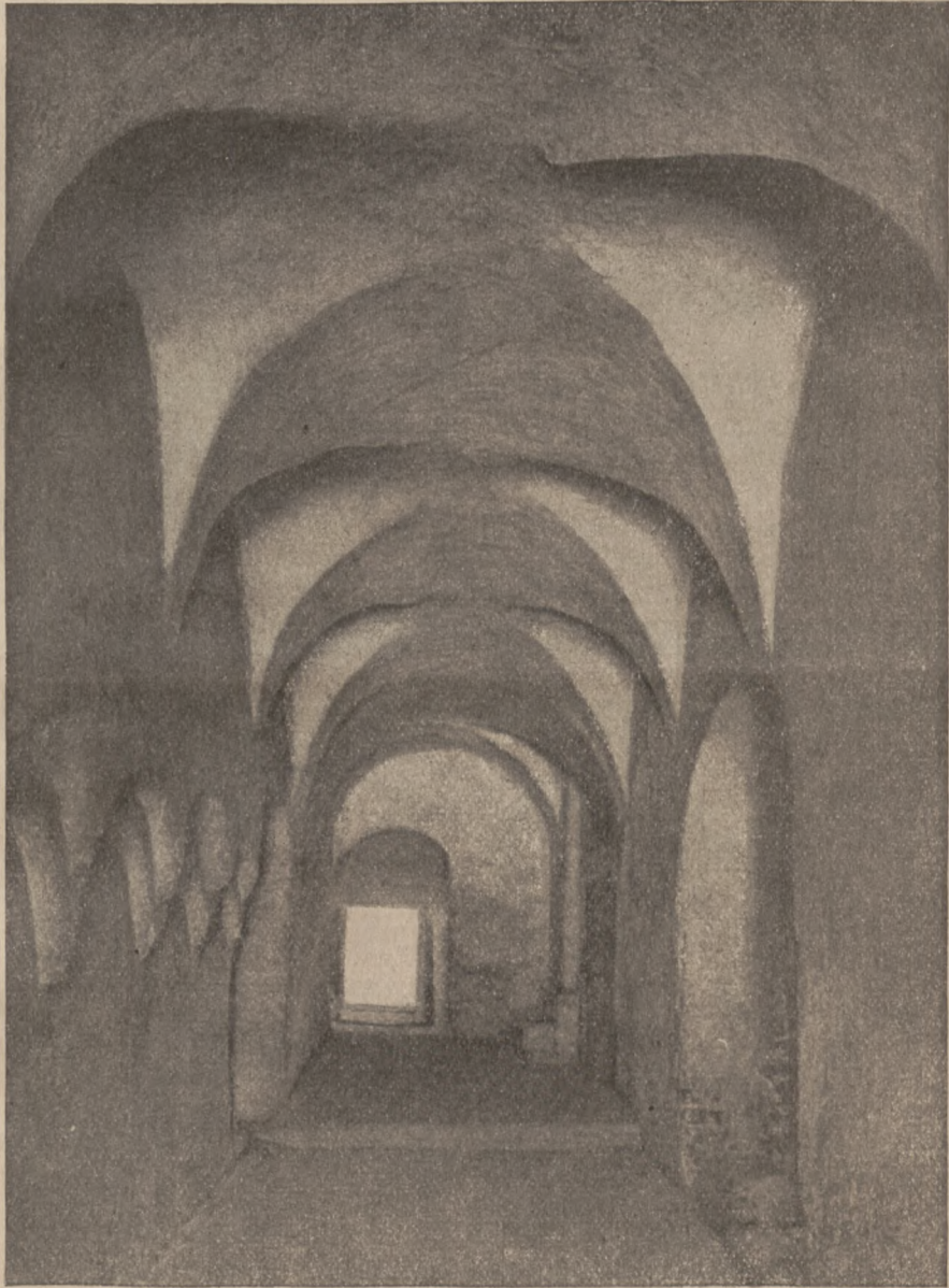
SIEŃ W RYNKU W PRZEMYŚLU Z CZASÓW KIEDY NIEZNANO JESZCZE BETONU.
