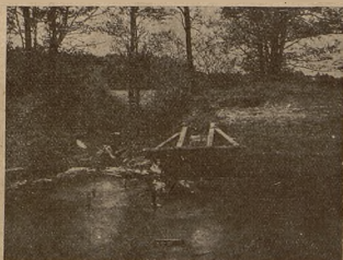
Kan. Og. — Dolny upust (wpust) przy słuzie IV przed odbudową.
