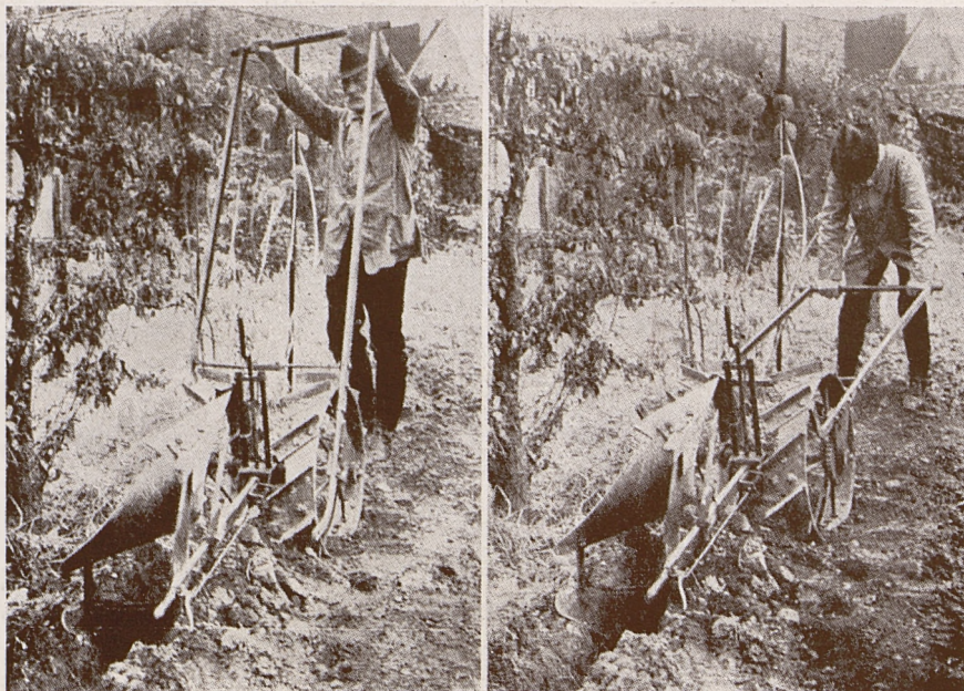
Traktor „Bos” o sile wolu, poruszany na podstawie fizycznego prawa dźwigni przez człowieka.
