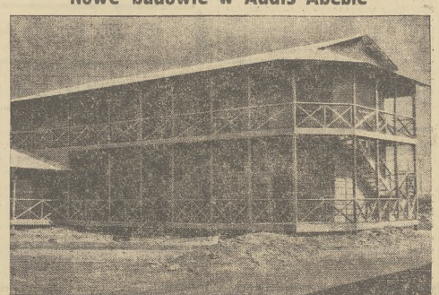
Dotychczas materialem budowlanym w Addis Abebie był przeważnie blacha. Oczywiście domki blaszane w czasie upałów nie były bynajmniej schronem przed kanikula. Obecnie Włosi przy budowie nowych domów używają, jak to widzimy na naszym zdjęciu — przeważnie drzewa.
