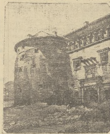
Najlepiej zachowana część zamku brzeżańskiego: Baszta i brama wjazdowa
