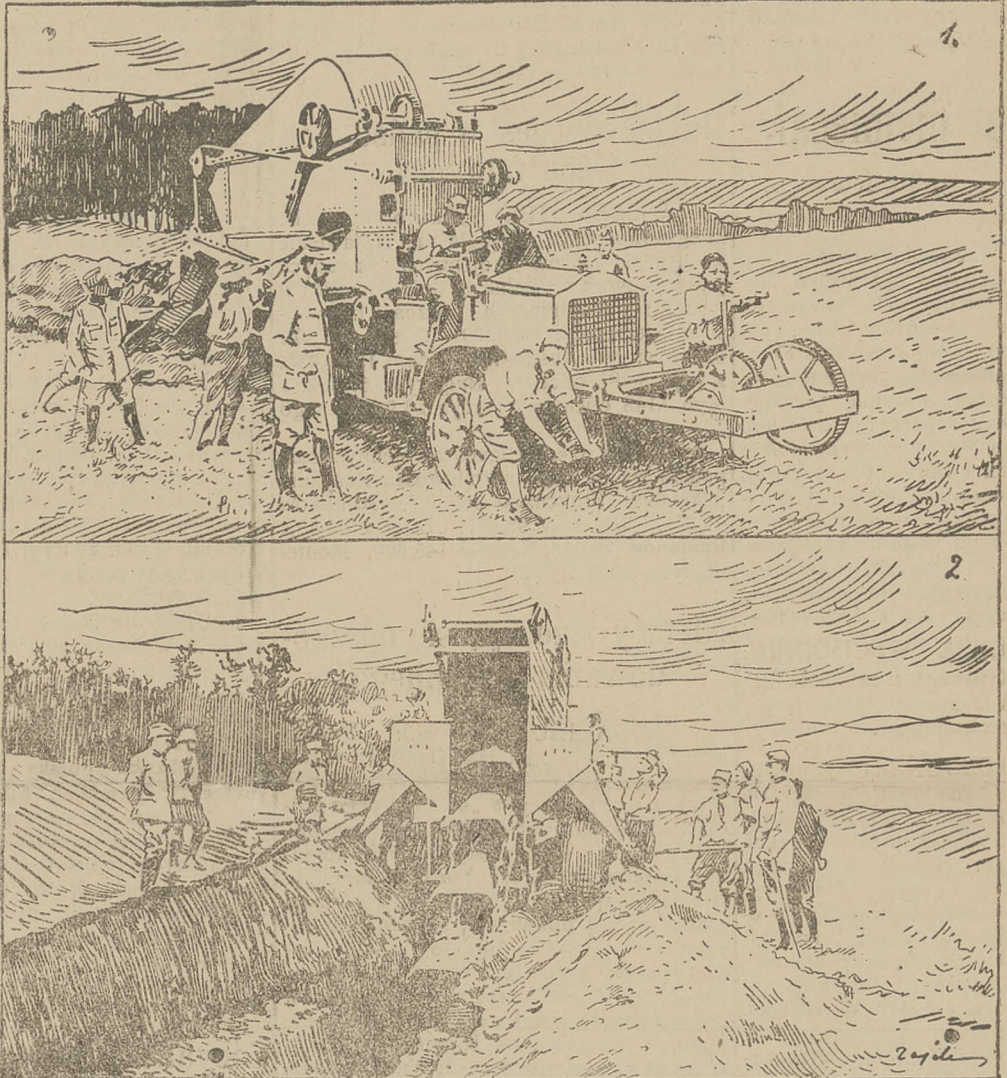
1) Maszyna przy pracy (kopanie rowu) widziana z przodu. 2) Ta sama maszyna widziana z tyłu.
