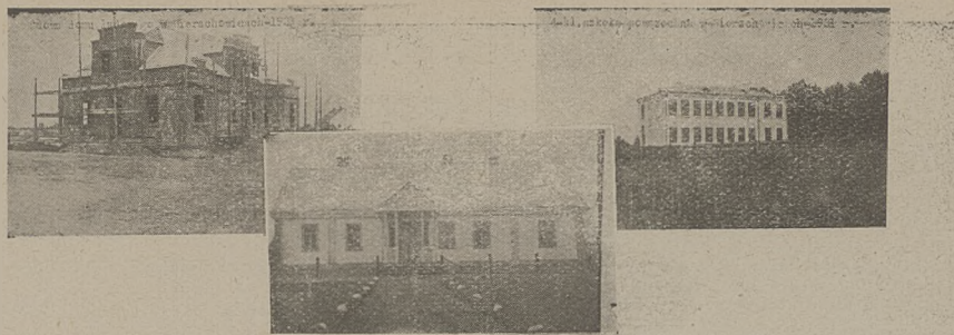
U góry na lewo: Budowa Domu Ludowego w Wierzchowicach, na prawo: szkoła powszechna, na dole: Gmach Urzędu Gminy Wierzchowice.
