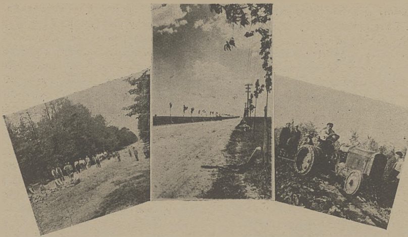
Roboty na drogach pow. kowelskiego. Od lewej do prawej: Budowa szosy wojewódzkiej Kowel-Włodzimierz; Fragment jednej z zadrzewionych dróg pow. kowelskiego; Fragment kapitalnej przebudowy dróg gminnych przy pomocy traktora i maszyn drogowych.
