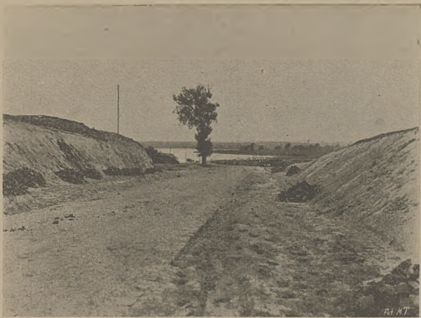
Budowa bazaltowej drogi gminnej Równe-Basowy Kąt.
