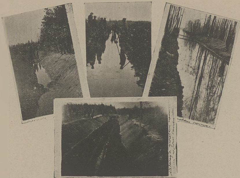
Widoki z dokonanych meljoracyj, sposobem szarwarkowym, w pow. sarneńskim.
